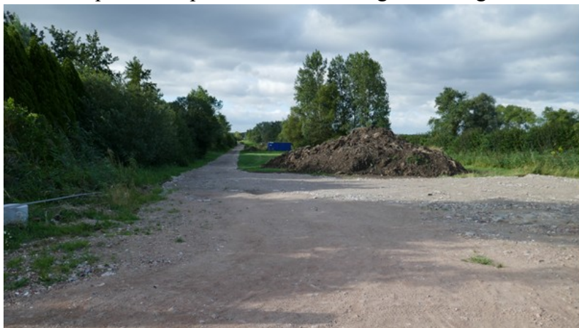
Aménagement d'une voirie privée sur le marais de Noordpeene
